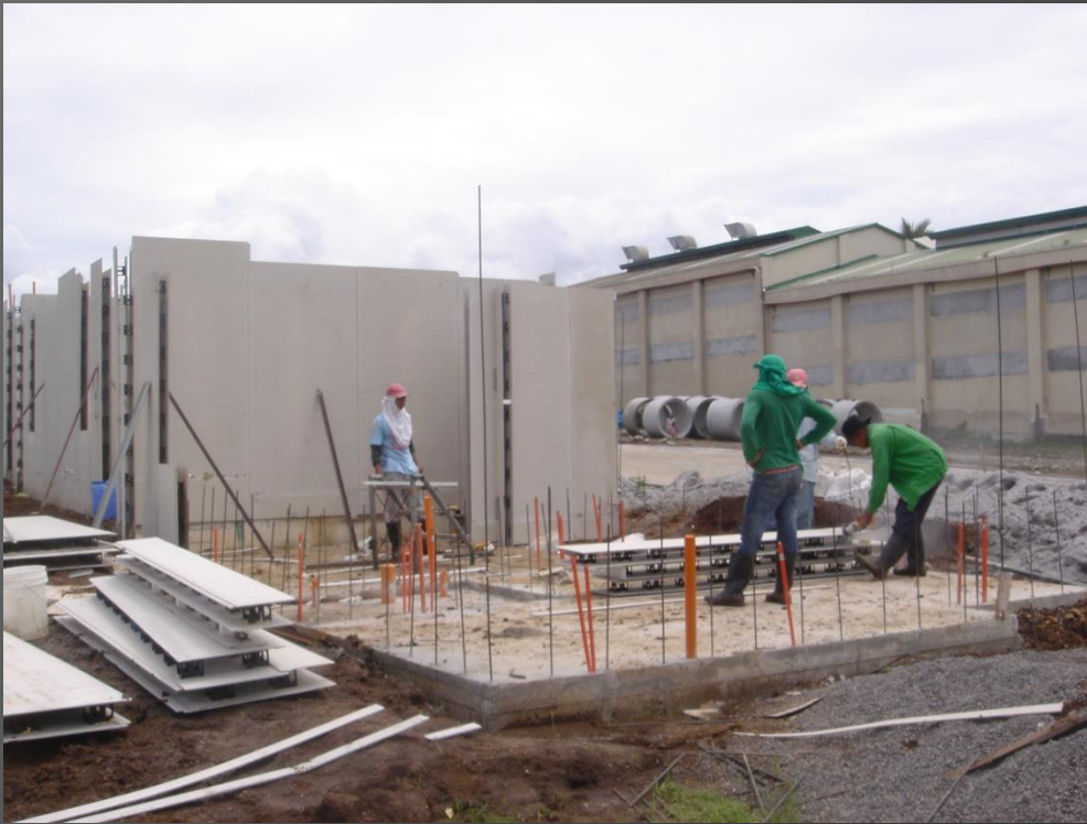
AFTER SLAB POUR BEGIN PANEL ERECTION
